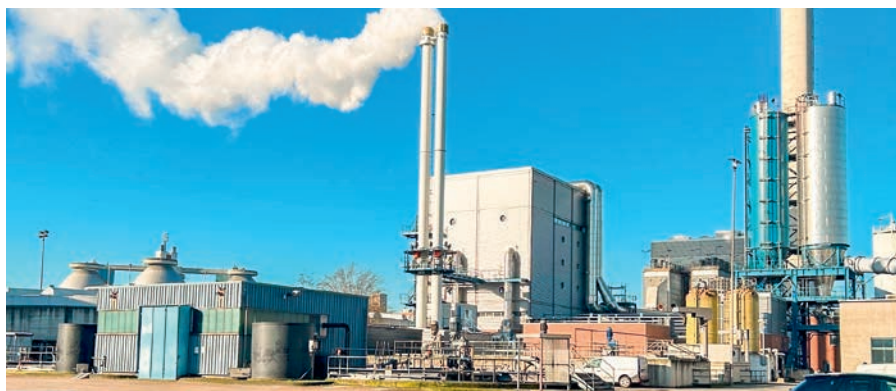
Anlage RRA Bottrop, Deutschland
