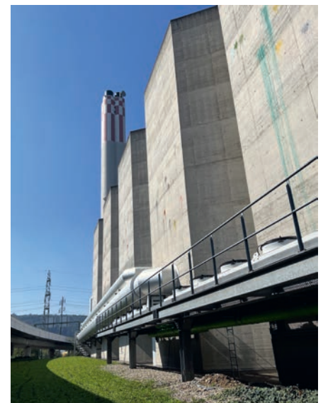
HHKW Aubrugg, Aussenansicht Ostfassade
